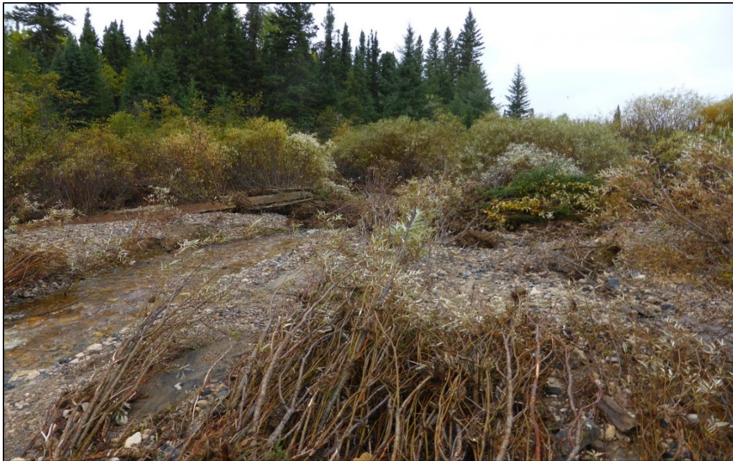
Figure 4. Photo des lieux en aval montrant du bois d'œuvre des ponceaux et des plantes aplaties du lit du cours d'eau (Source : BST)
