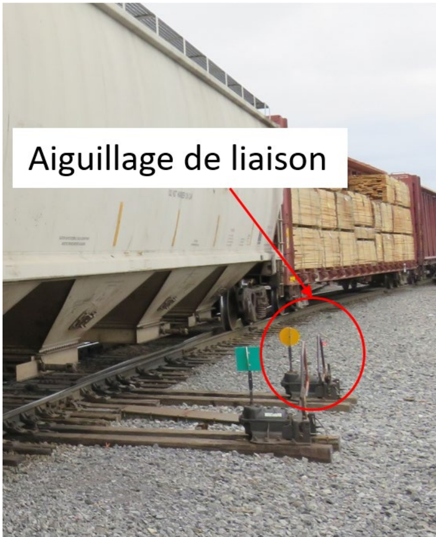
Figure 5. Aiguillage de liaison 2WL/WL reliant la voie 2WL et la voie WL, en position renversée (Source : BST)
