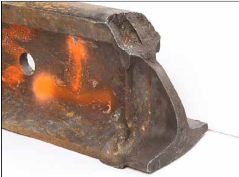
Figure 15. Photo de la soudure aluminothermique à l'extrémité est du rail d'origine retiré présentant une fissuration verticale longitudinale du champignon
