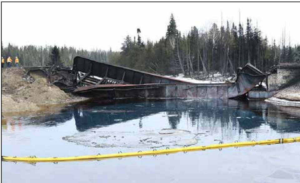
Figure 4. Pont enjambant la rivière Makami
