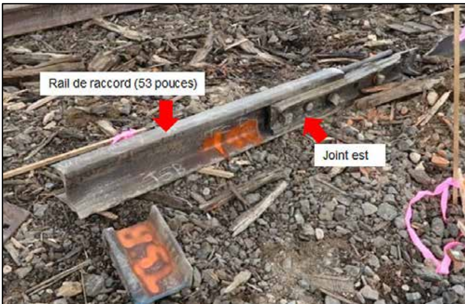
Figure 6. Rail sud avec joint est reliant le rail de raccord et le rail d'origine
