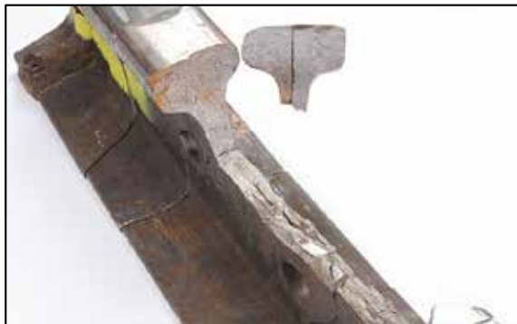
Figure A1. Fissuration verticale longitudinale du champignon constatée dans le champignon et l'âme du rail
