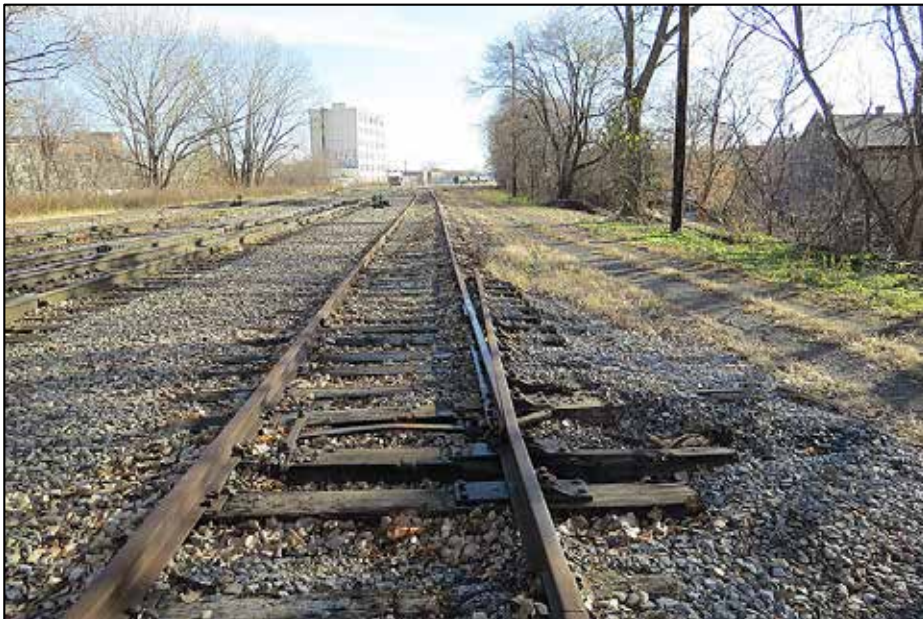
Photo 3. Dérailleur à aiguille
