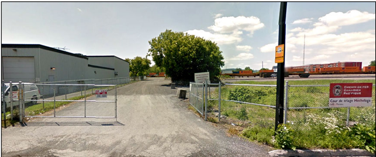
Photo 5. Clôture à maillons de chaîne au triage Hochelaga (Source : Google Earth)
