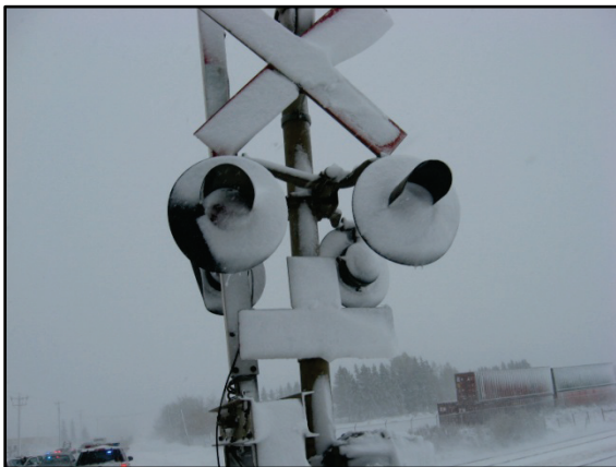
Photo 1. Signal nord, feux orientés vers le nord
