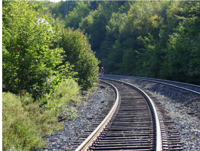
Photo 1. Courbure de la voie et lignes de visibilité au point milliaire 1,3, vues de l'ouest
