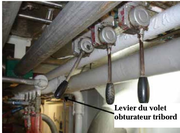
Photo 3. Levier hydraulique en position de fermeture.
