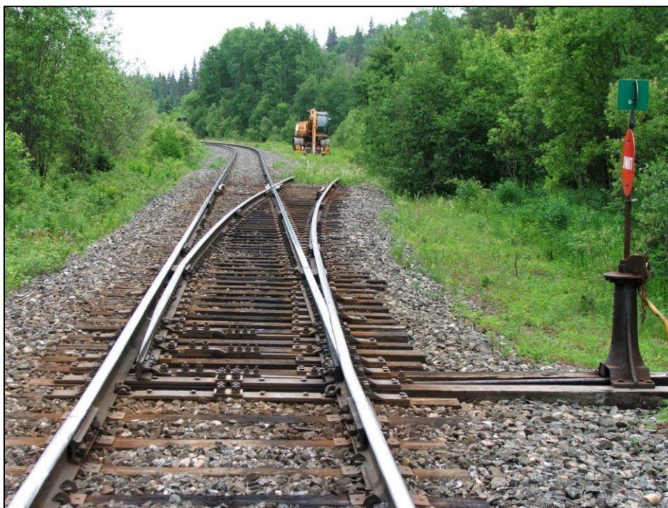
Figure 5. Aiguillage à manœuvre manuelle typique en régulation de l'occupation de la voie (Source : BST)
