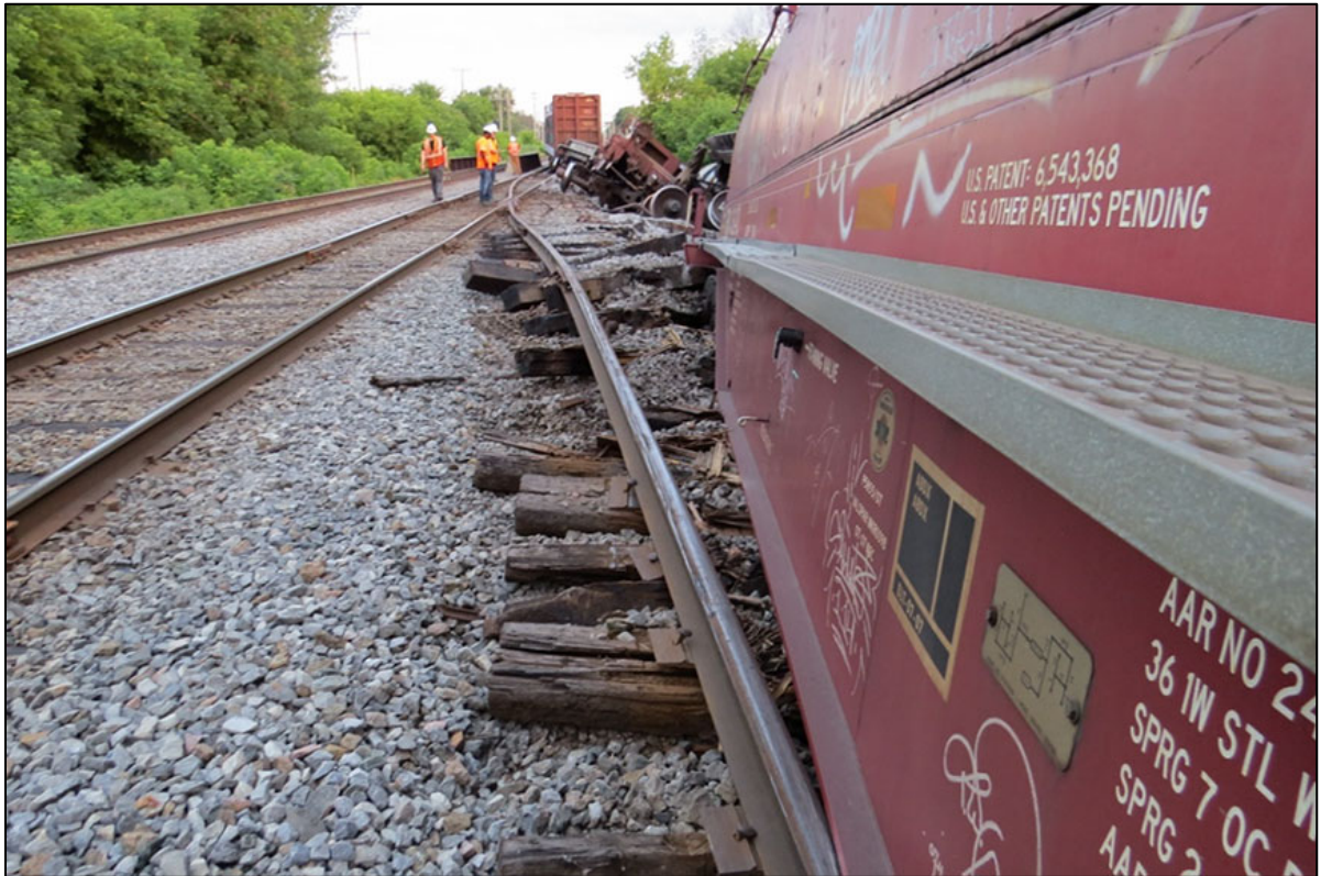
Figure 4. Vue vers le nord des dommages à l'extrémité nord de la voie CC Long Siding
