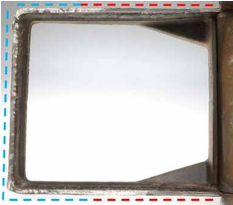
Figure 5. Surface de rupture de la zone soudée fixant la colonne à la base de la grue (la zone plane est définie par le pointillé bleu, et la zone biseautée, par le pointillé rouge)
