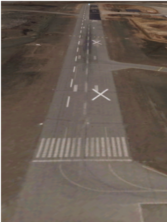
Vue aérienne illustrant les marques de piste utilisées à l'aéroport d'Iqaluit pendant les travaux
