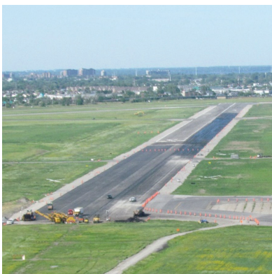
Photo aérienne illustrant les marques de piste utilisées pour la piste 24R à l'aéroport de Montréal/St-Hubert pendant la 1 re phase des travaux
