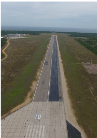
Photo aérienne de la piste 10 de l'aéroport de Baie-Comeau pendant les travaux de réfection effectués sur le côté sud de la piste en juin 2018
